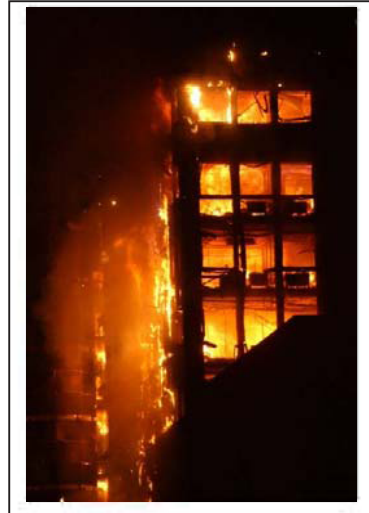
Şekil ÖÇ3.1 Üstteki Madrid'deki Windsor Kulesi'nde yangının yayılması. (IECA'nın izniyle, İspanya)
