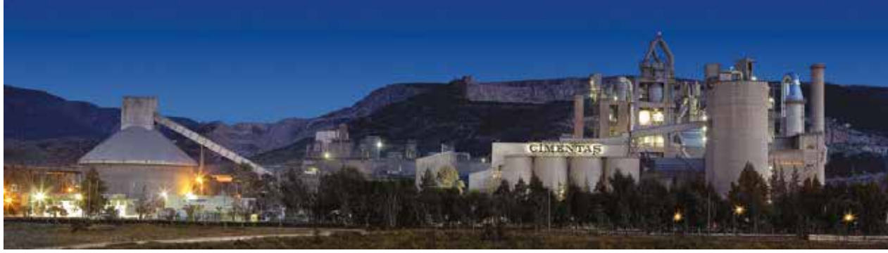
Çimentaş İzmir Fabrikası / Çimentaş İzmir Plant
