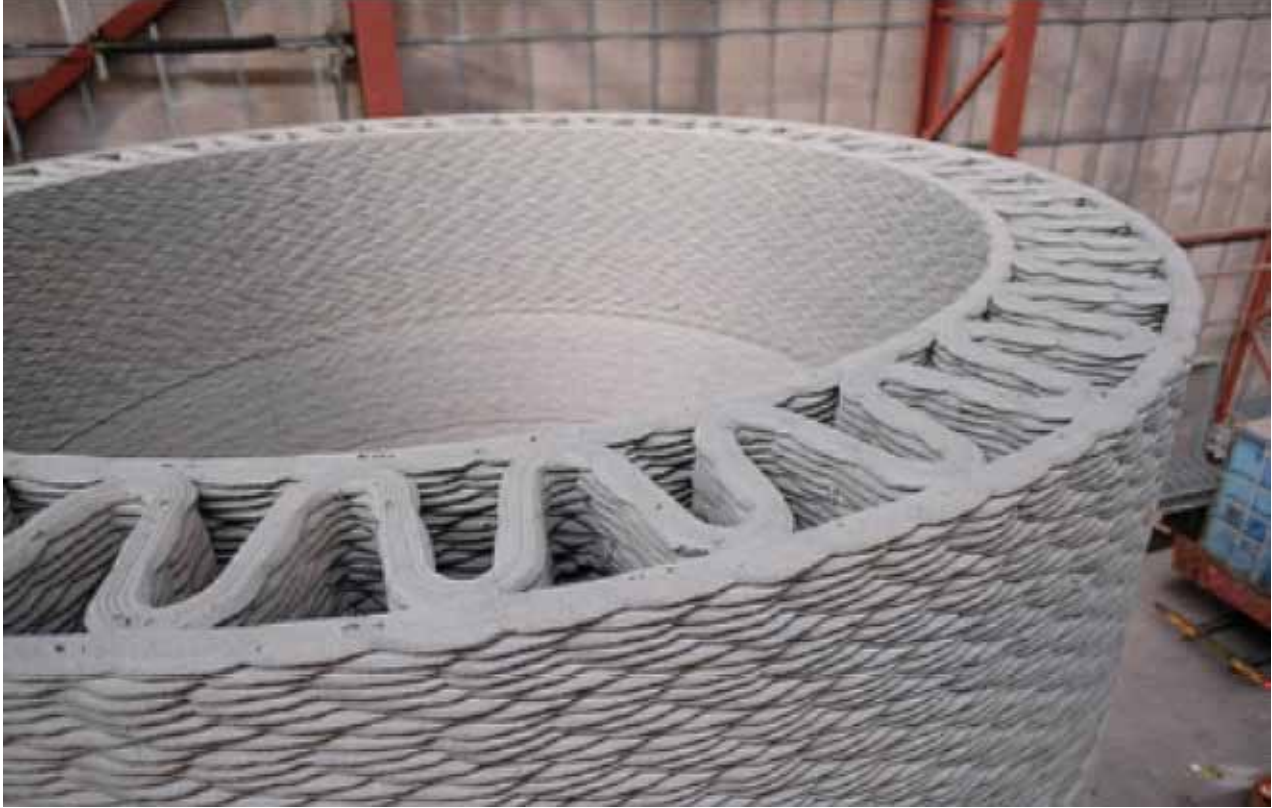
3B yazıcı ile beton dökümü, Rüzgar Türbini [11] Concrete casting with 3D printer, Wind Turbine [11]
