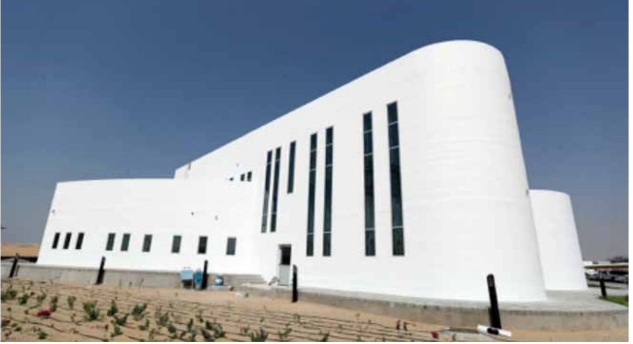
Dubai'de 3B yazıcı ile yapılan en büyük bina [12] Largest building made with 3D printing in Dubai [12]
