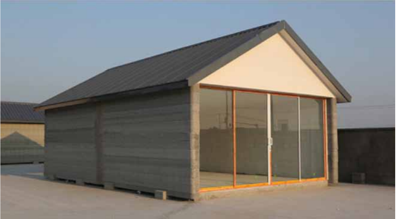
Çin'de 3B yazıcı ile yapılan bir ev örneği [13] An example of a house made with a 3D printer in China [13]
