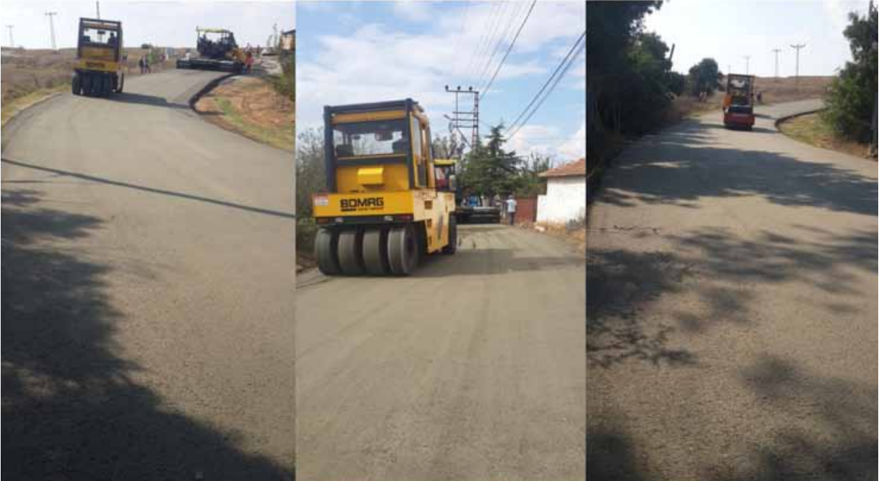
Şekil 10: Kırklareli İl Özel İdaresi tarafından 2018 yılında yapılan SSB Kaplama Uygulaması (Kaynak TÜRKÇİMENTO)
