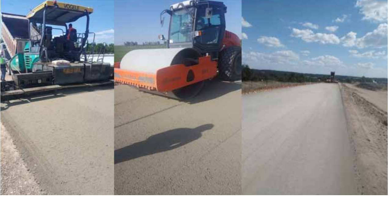
Şekil 9: Edirne İl Özel İdaresi tarafından 2018 yılında yapılan SSB Kaplama Uygulaması (Kaynak TÜRKÇİMENTO)
