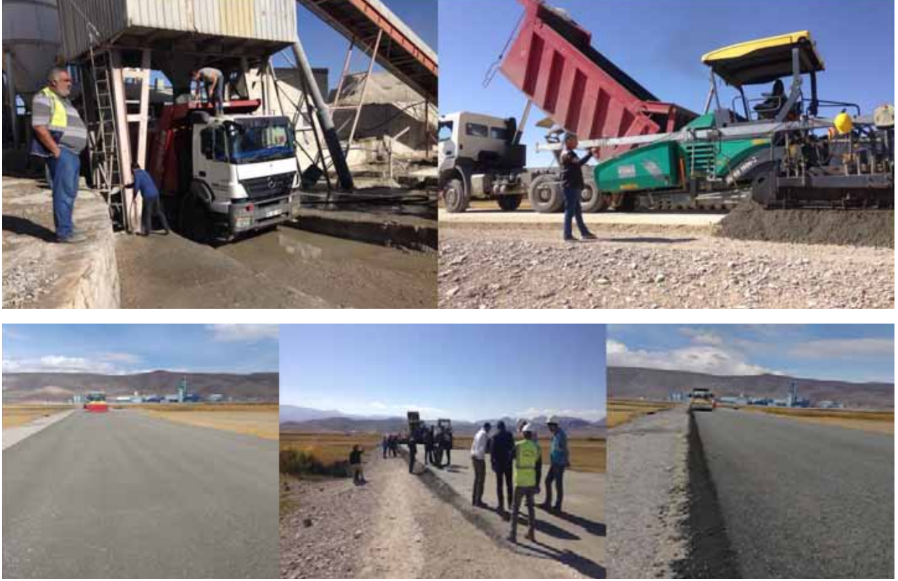
Şekil 11: Ağrı Valiliği tarafından 2018 yılında yapılan SSB Kaplama Uygulaması (Kaynak TÜRKÇİMENTO)
