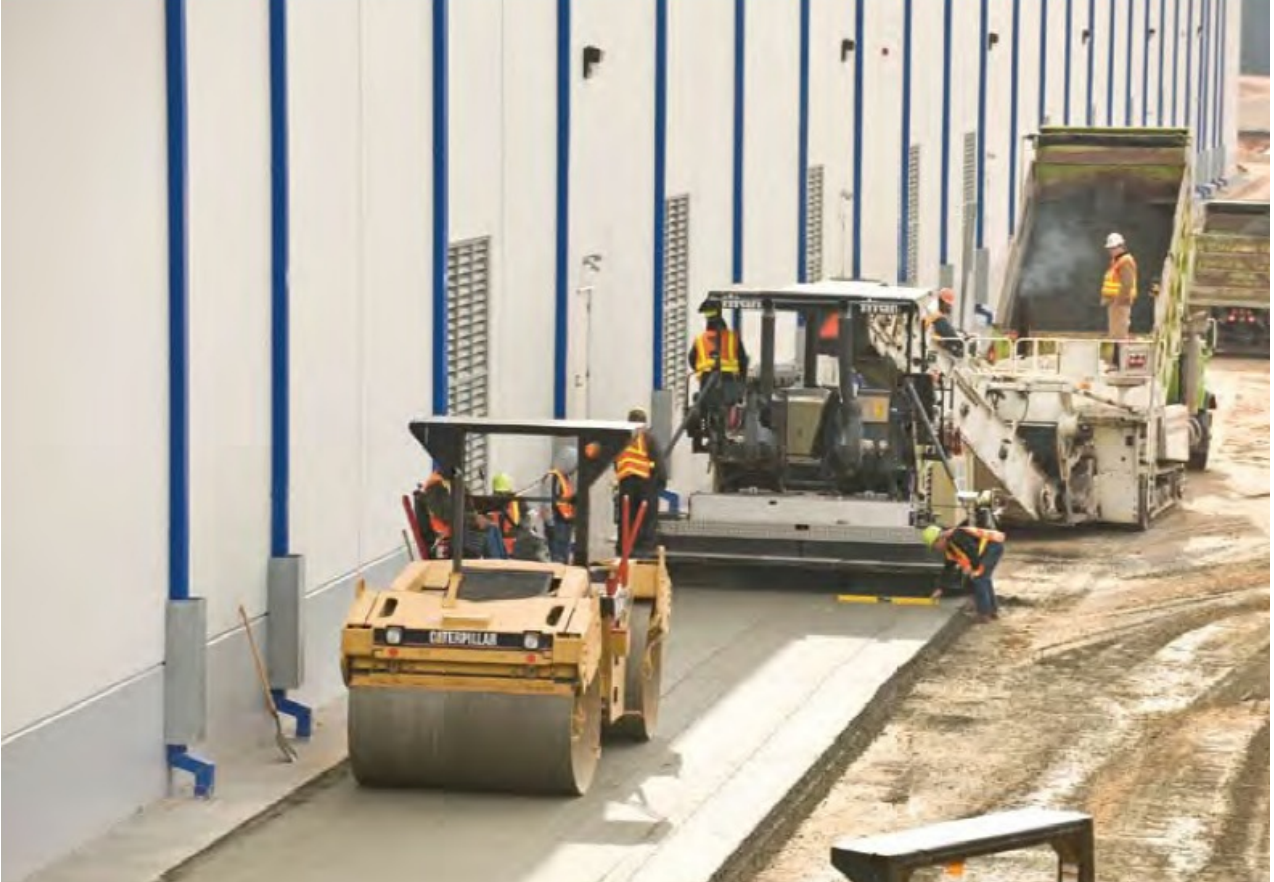
Şekil 2: Silindirle sıkıştırılmış betonun serimi ve sıkıştırılması (Harrington, 2010).
