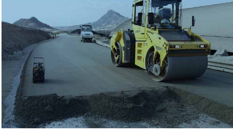
Şekil 6: SSB Betonun silindir ile sıkıştırılması (Tranter ve Merino, 2019)
