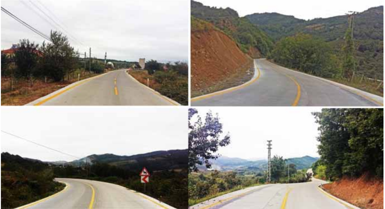
Şekil 12: Köydes ve Kırdes Projeleri kapsamında beton yol uygulamaları (Kaynak TÜRKÇİMENTO)
