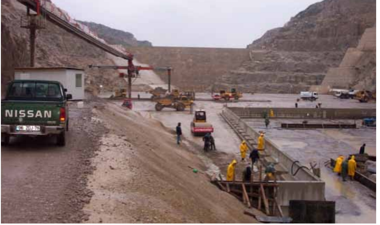
Şekil 3: Çine Barajında kullanılan prekast segmentleri tabandan döşenmeye başlanması.
