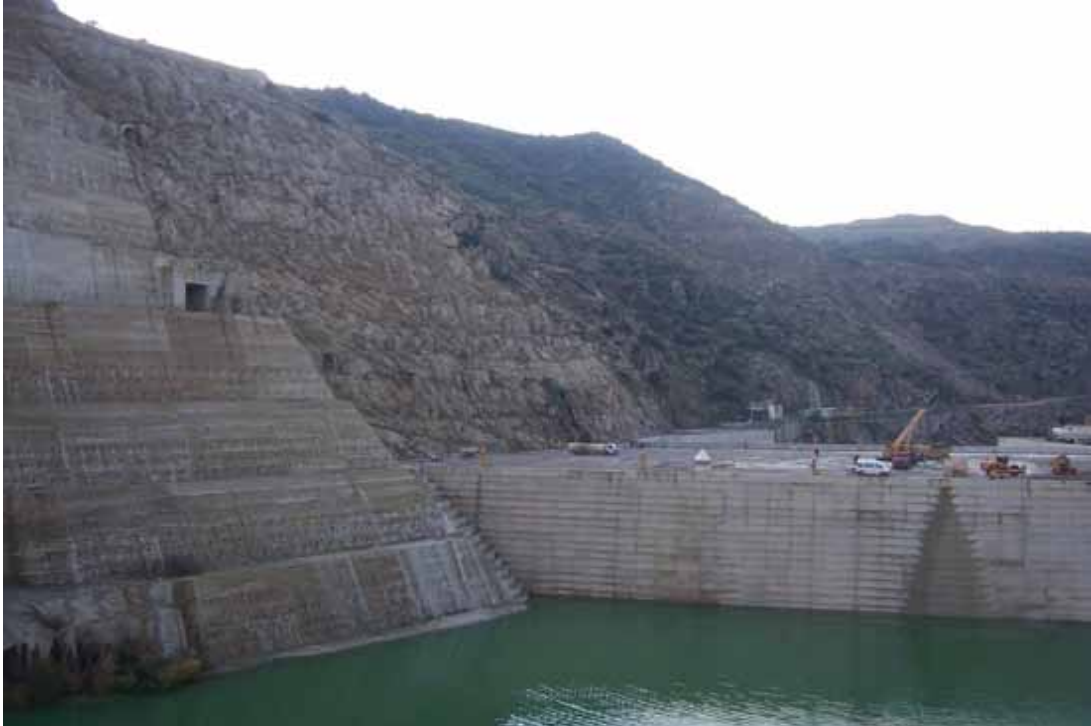
Şekil 4: Çine Barajında kullanılan prekast segmentlerin görünümü.
