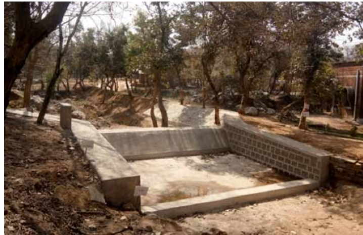
Şekil 2.6: LC3'ten yapılan, Orchha'daki kontrol bendi. Kaynak: [20]
