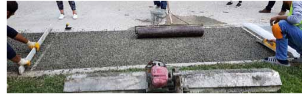
(d) Betonun silindir master ile yüzeyinin düzeltilmesi
