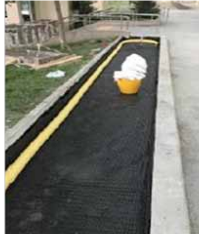
(c) Membran koruyucu tabaka ve drenaj borusu
