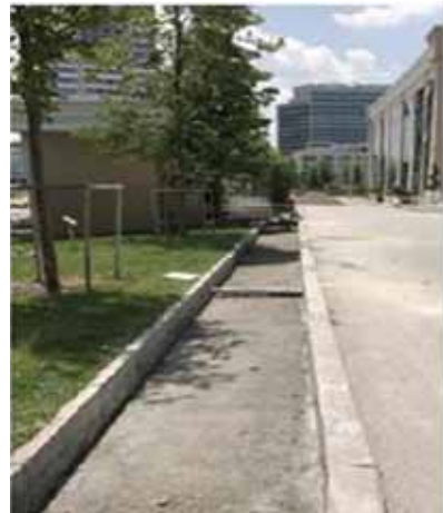
(a) Üstyapı tabanının tesviyesi ve beton dökümü
