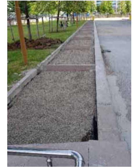
(b) Derz plakalarının yerleştirilmesi ve sabitlenmesi
