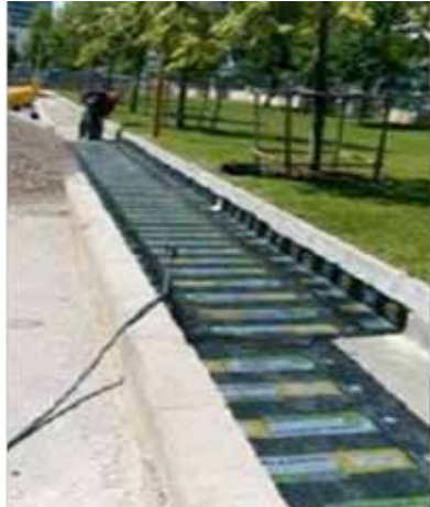
(b) Bitümlü membran ile geçirimsiz katman
