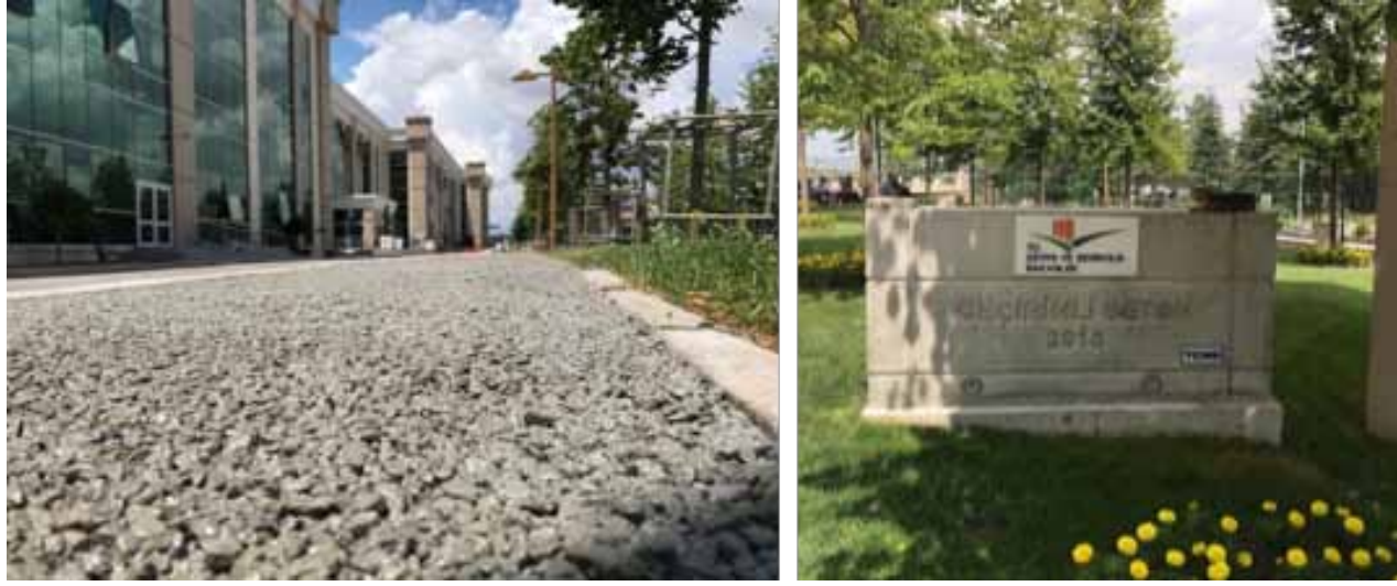
Şekil 12: Uygulama sonrası görünüm Figure 12: The appearance after application
