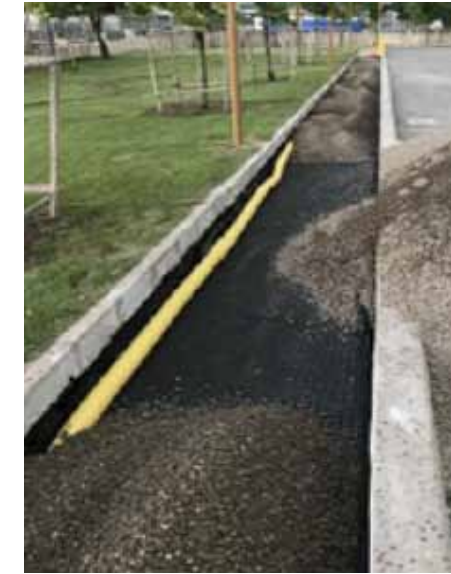
(a) İri agregata ile temel ve rezervuar katmanı yapımı
