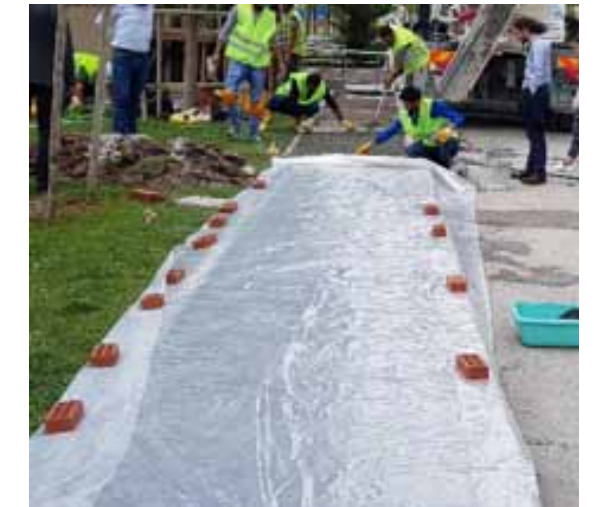
(e) Plastik bir örtü ile betonun bakımının yapılması (e) Curing of concrete with a plastic cover
