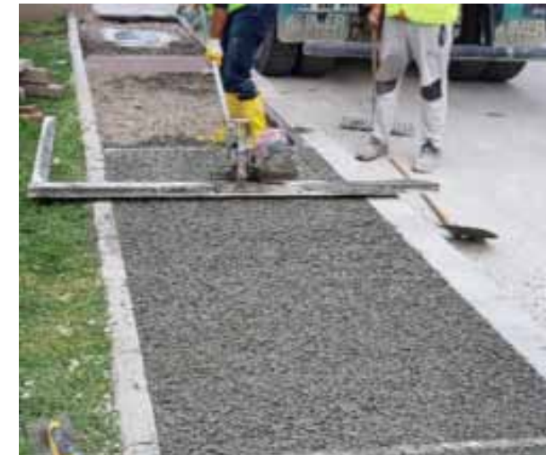
(c) Geçirimli betonun serilmesi ve titreşimli master ile sıkıştırılması (c) Laying the pervious concrete and compacting with vibrating screed
