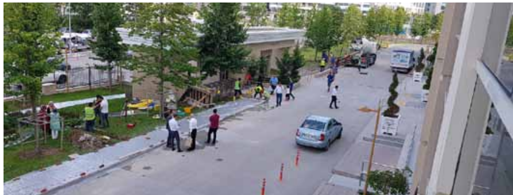
Şekil 10: Geçirimli beton uygulamasından genel bir görünüm Figure 10: A general view from the pervious concrete application
