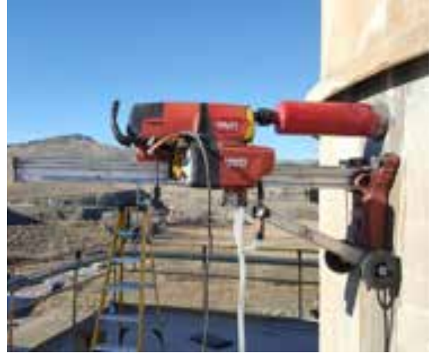
Üretim sırasında hava şoku montajı: Karotlu matkap dış duvarı ve refrakteri deler ve ardından otomatik olarak geri çekilir
