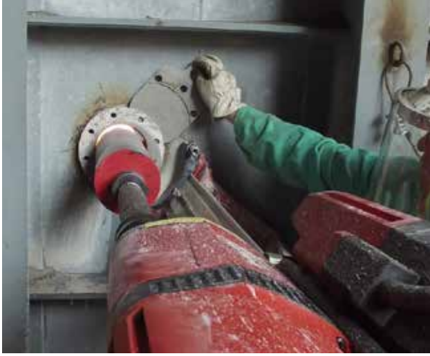
Üretim esnasında bir ön ısıtıcıda yeni bir hava şoku nozulu için delik açma çalışması
