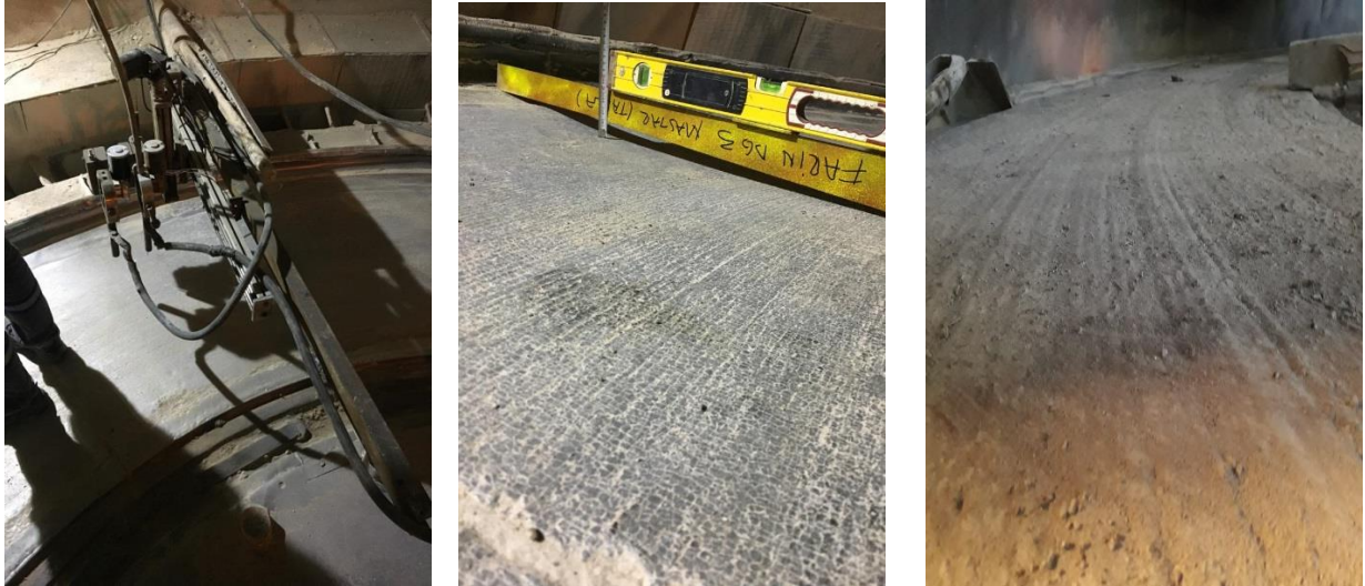
Resim 13- Tabla kaynağı, kaynak öncesi aşınmış yüzey ve kaynak sonrası tabla yüzeyi
