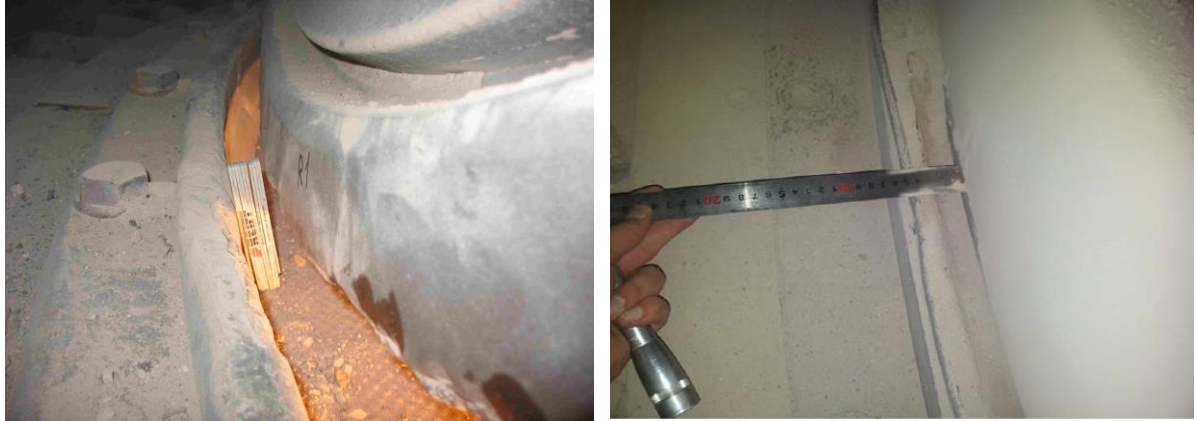
Resim 14- Vals ve dam ring arası mesafe ölçümleri
