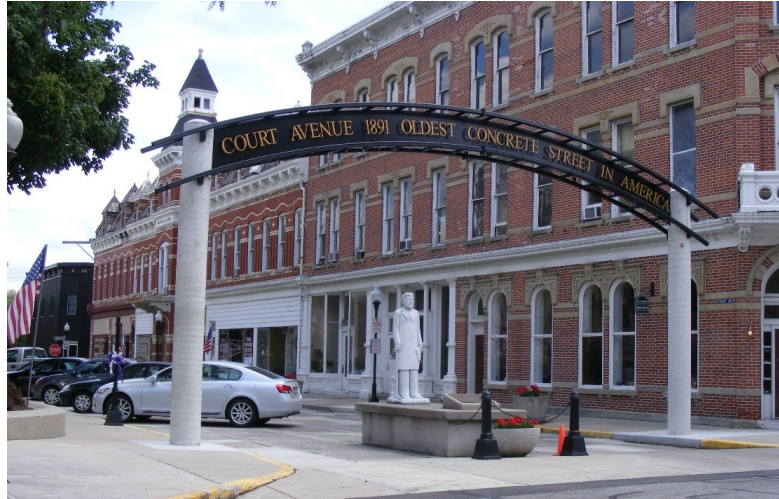
Resim 32. Ohio’da günümüzde de hizmet veren ilk beton yol
