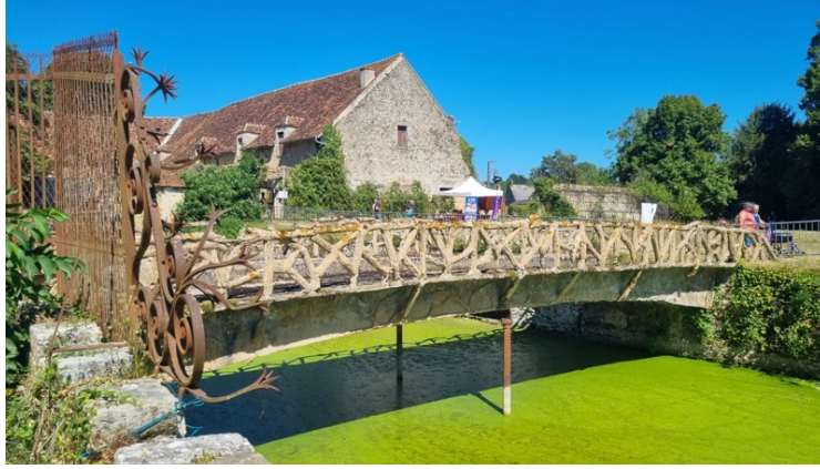
Resim 27. 1875 yılında Fransa’da Monier tarafından tasarlanmış Dünya’nın ilk betonarme köprüsü
