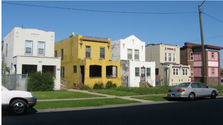
Resim 36. Edison'un tek döküm yöntemi ile inşa edilen evler (Indiana, ABD)
