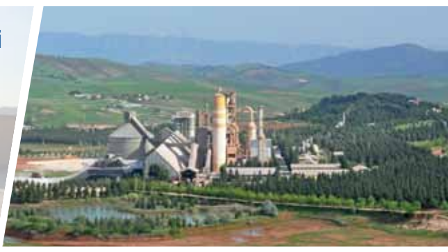
26 hazır beton tesisi
