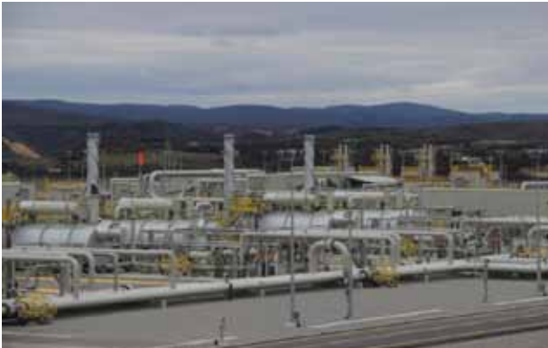
Türk Akım Alım Terminali Projesi
