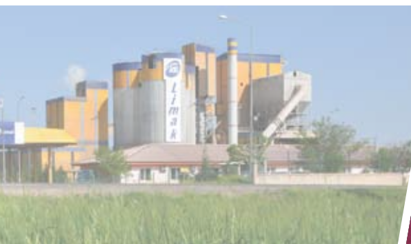
1 Bims üretim tesisi
