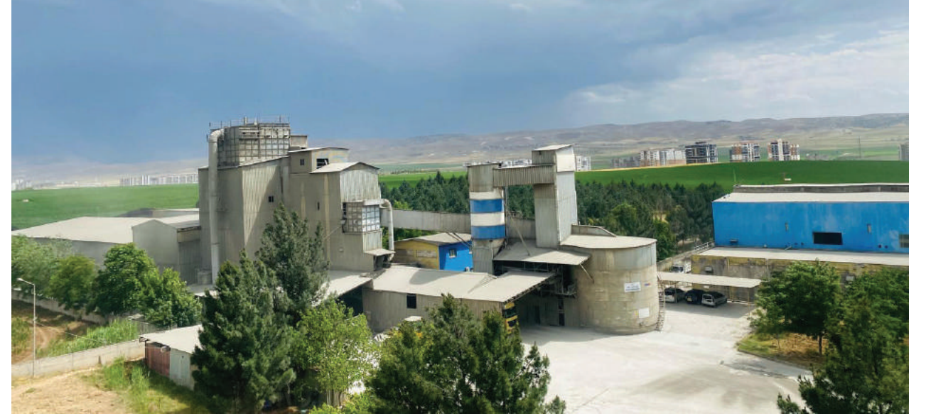
Batman Öğütme ve Paketleme Tesisi
